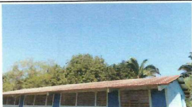
Foto1: MANO DE OBRA ESPECIALIZADA, EN LA CUBIERTA DE LA LAMINA
