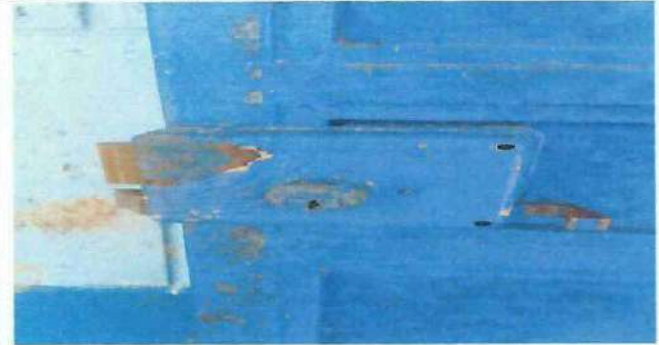
Foto 6: PUERTAS DE METAL, MANTENIMIENTO DE LIJADO Y PINTURA DE LAS PUERTAS PORQUE ES NOTORIO LA NECESIDAD.
