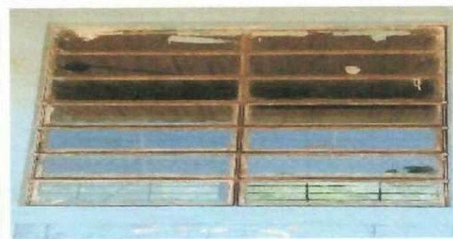
Foto 3: VENTANAS (BALCONES) , INSTALACION PARA UN MEJOR AMBIENTE DENTRO DE LA MISMA
