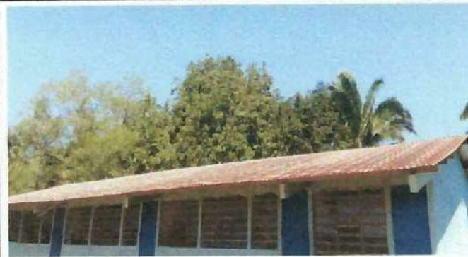
Foto 2: MANO DE OBRA ESPECIALIZADA, EN LA CUBIERTA DE LA LAMINA
