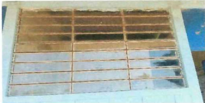
Foto1: VENTANAS (BALCONES),INSTALACION DE BALCONES EN VENTANAS
