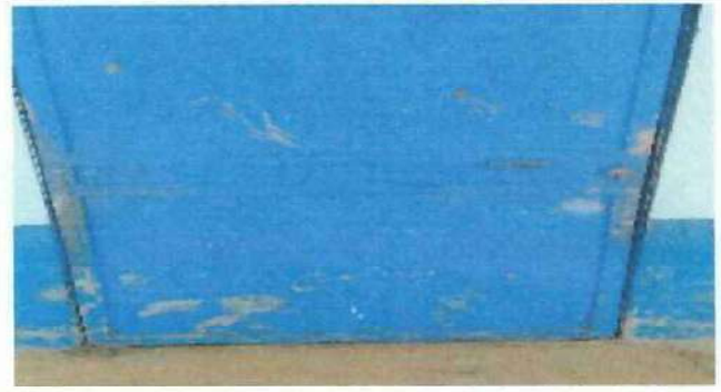
Foto 4: PUERTAS DE METAL, MANTENIMIENTO DE PUERTAS EN PINTURA
