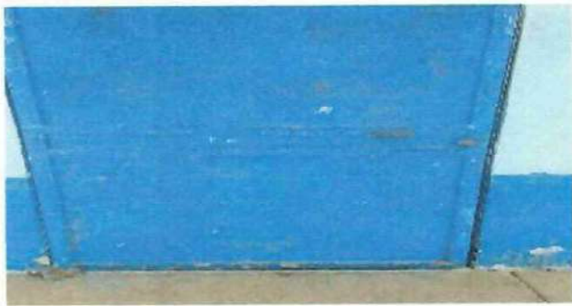
Foto 3: PUERTAS DE METAL, MANTENIMIENTO DE LAS PUERTAS DE METAL
