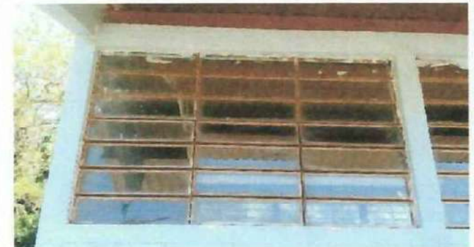
Foto 4: VENTANAS( BALCONES), INSTALACION DE BALCONES PARA MEJORAS DEL CENTRO EDUCATIVO
